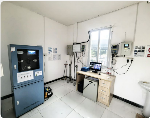
成都丰田纺污水处理站
